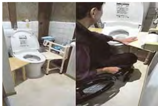
トイレへの移乗用台の設置
